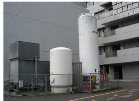
高圧ガス貯蔵施設
