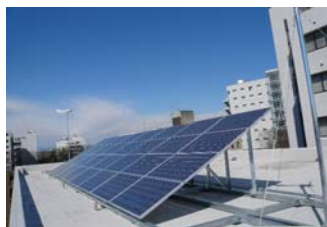
太陽光・風力発電設備
