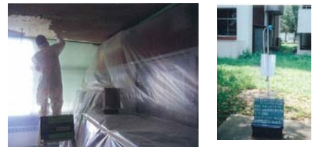
アスベスト除去・環境測定
